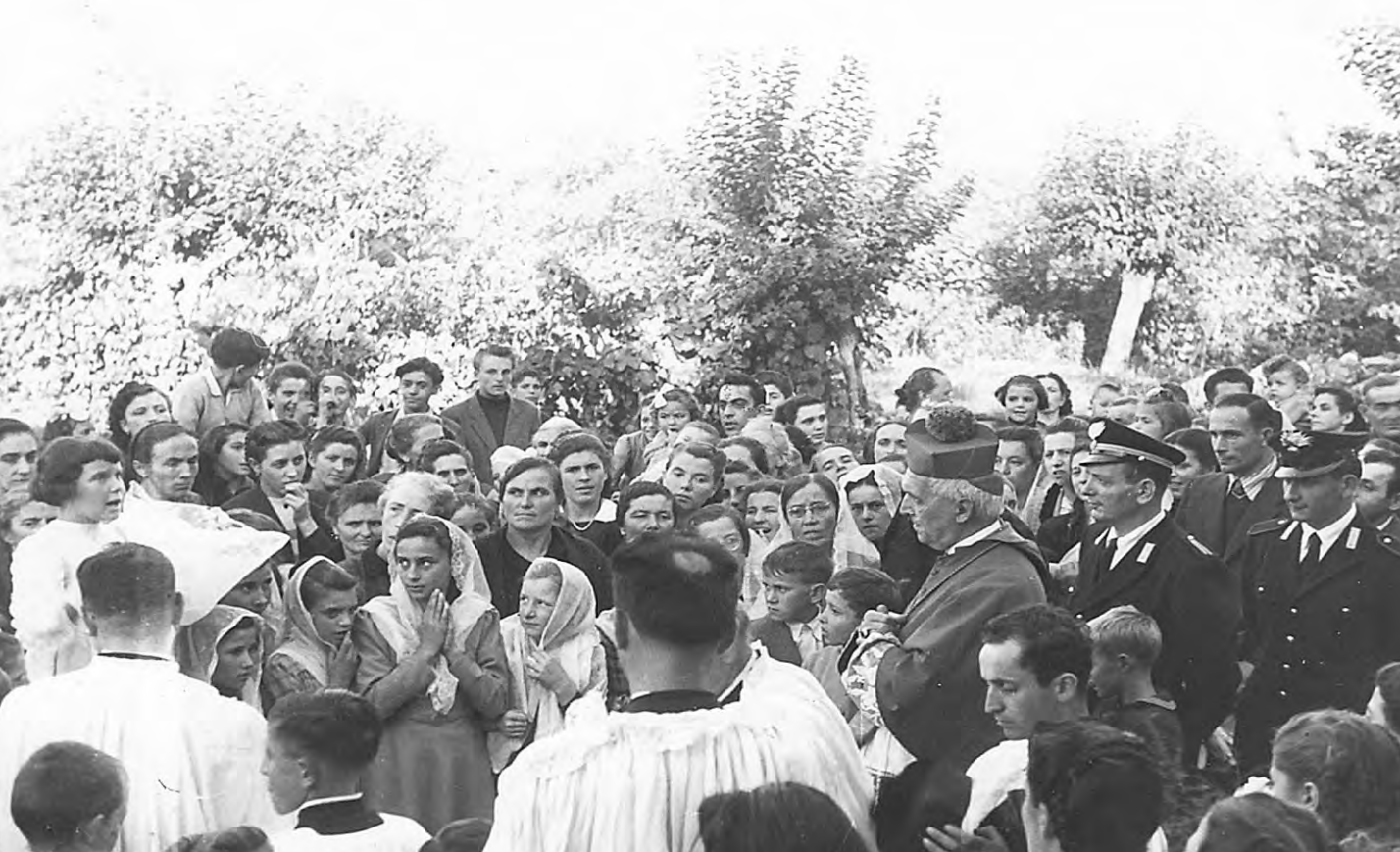
1 ottobre 1950 - Mons. Bernareggi incontra la gente in attesa della benedizione e posa della prima pietra della nuova chiesa.
