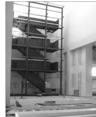
Sistemazione della scala e dei sostegni del nuovo velario.
