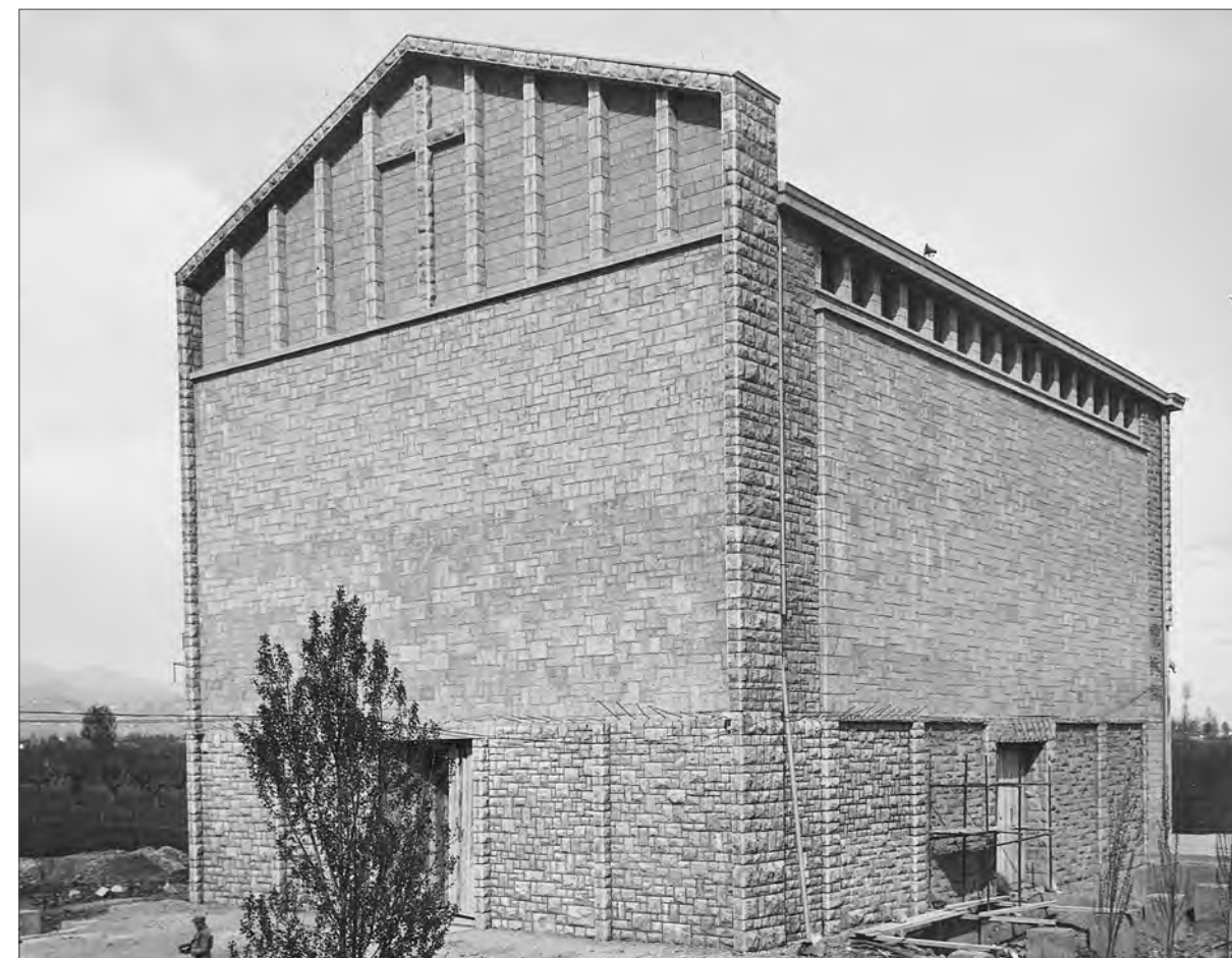
La facciata, alta 23 m, con all'interno una croce di 6 m, fu pronta nell'ottobre 1954.
