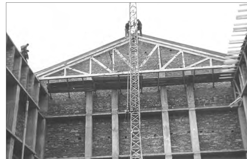
Alla fine di febbraio del 1955 la ditta Romano di Padova innalzò all'interno il "falcone" (gru) che sollevò da terra le capriate poste a sostegno del tetto.
