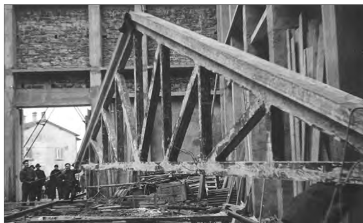
Le capriate del tetto della chiesa furono preparate all'interno prima dell'inverno ad opera di un valdimagnino, "ol locari".
