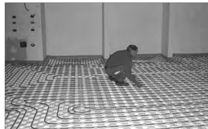
Impianto a terra del riscaldamento. Rimozione dei marmi dell'altare e del ciborio.
