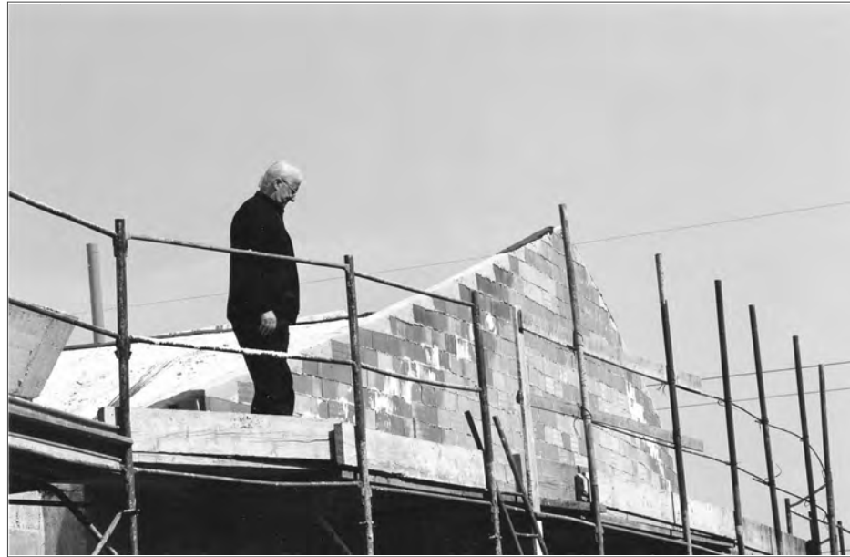
1999, 2 aprile. Don Tommaso sui ponteggi del cantiere dell'oratorio.
