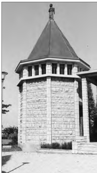
Il nuovo battistero e i portici laterali furono benedetti e inaugurati domenica 22 agosto 1965 dal vescovo Mons. Gaddi.
