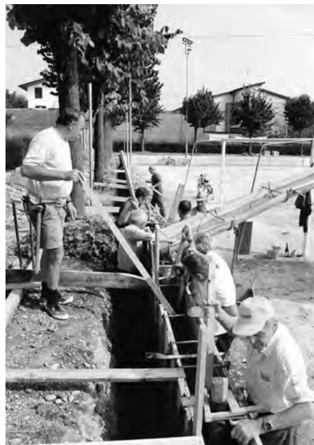
Costruzione del muro di cinta del campo sportivo dopo il riempimento della buca nel 1995.
