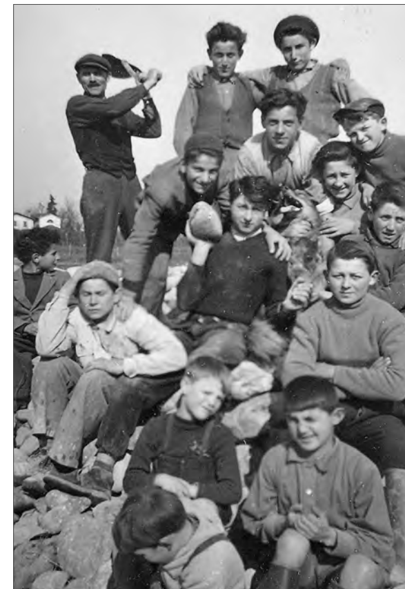
Nella prima domenica di marzo del 1954 la gente incominciò a scavare le fondamenta completando il lavoro in tre mesi con 1000 quintali di cemento e una montagna di sabbia e sassi raccolti al fiume da decine di ragazzi e uomini a partire dal 1950.
