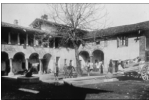
Cascina abbattuta, sul luogo furono realizzate le pensiline
